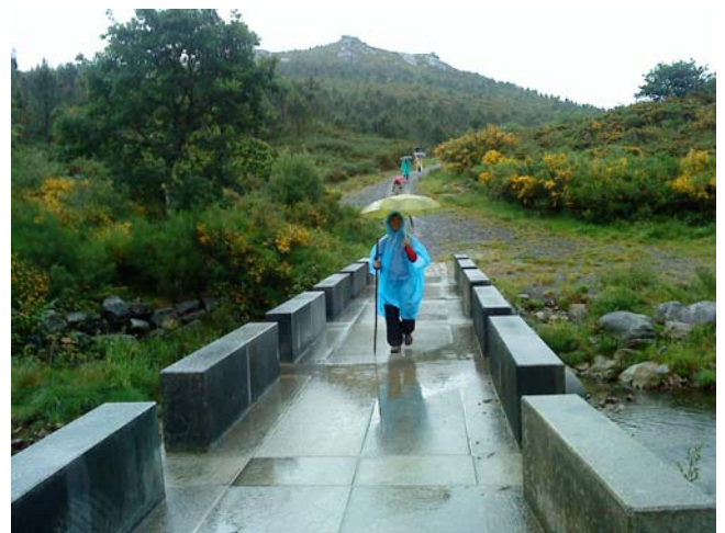
De Olveiroa hacia Hospital. Puente de Valderripas
