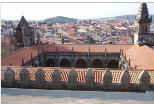
Restos de la fortificación
